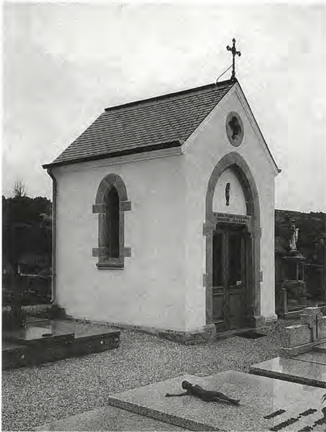
Fotos: nach der Restaurierung
