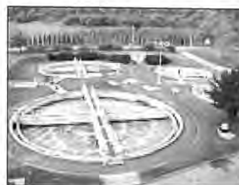
Station d'épuration Blesbruck
