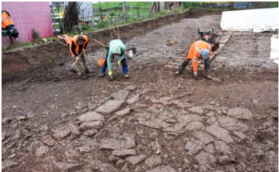
Pendant le nettoyage du chemin d'accès au bâtiment rectangulaire
