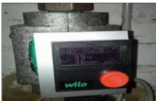
Abb. 2: Im „Alen Atelier“ der Gemeinde wurde die vorhandene ungeregelte Pumpe bereits durch eine stromsparende Hocheffizienzumwälzpumpe ersetzt.
