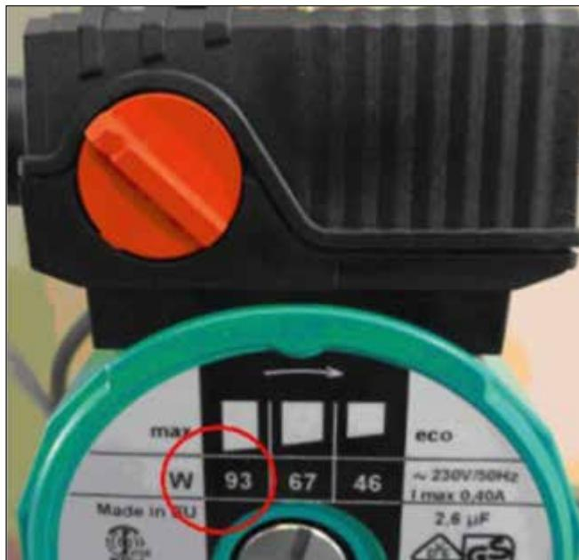
Abb. 1: An der abgebildeten Heizungsumwälzpumpe können drei Leistungsstufen eingestellt werden (roter Schalter). Eingestellt ist dabei die Stufe 3, bei der die Leistungsaufnahme laut Typenschild 93 Watt (W) beträgt.
