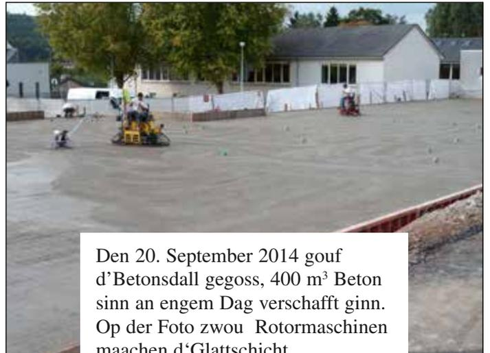
Den 20. September 2014 gouf d'Betonsdall gegoss, 400 m<sup>3</sup> Beton sinn an engem Dag verschafft ginn. Op der Foto zwou Rotormaschinen maachen d'Glattschicht.
